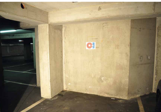
Abb. 4: Innenwand einer Tiefgarage
