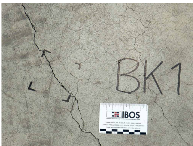
Abb. 4: Markierung eines Bohrkernansatzes über dem Riss eines großmaschigen Netzes
