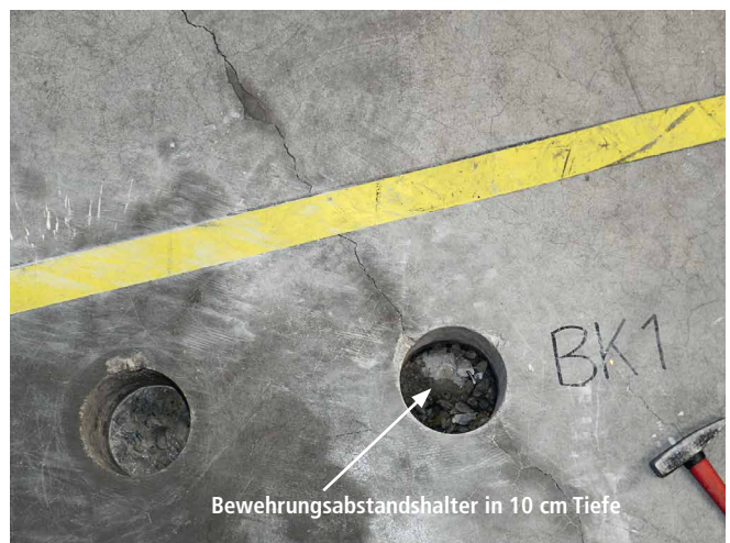
Abb. 5: Bohrstelle BK1a und BK1b über dem großmaschigen Riss bzw. daneben
