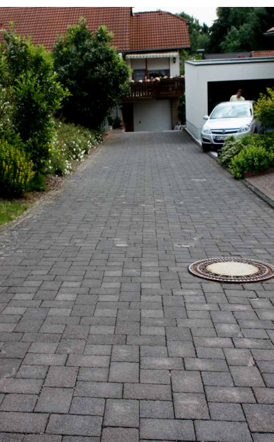
Abb. 1 a+b: Frost-Tausalz-Schäden an Betonpflastersteinen einer ruhigen Anliegerstraße
