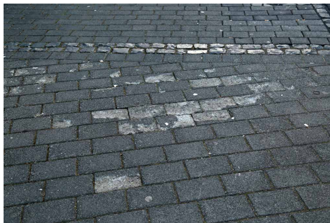
Abb. 1 a+b: Frost-Tausalz-Schäden an Betonpflastersteinen einer ruhigen Anliegerstraße
