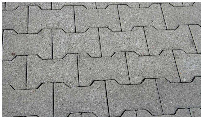
Abb. 2 a+b: Zementsteinabwitterungen an Betonpflastersteinen mit einer geringen Abwitterungstiefe
