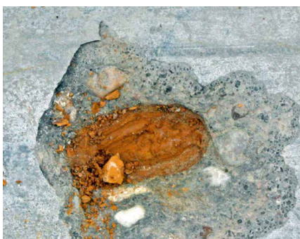
Abb. 3 a+b: Zementsteinabwitterungen oberhalb einzelner verwitterungsunbeständiger Gesteinskörner
