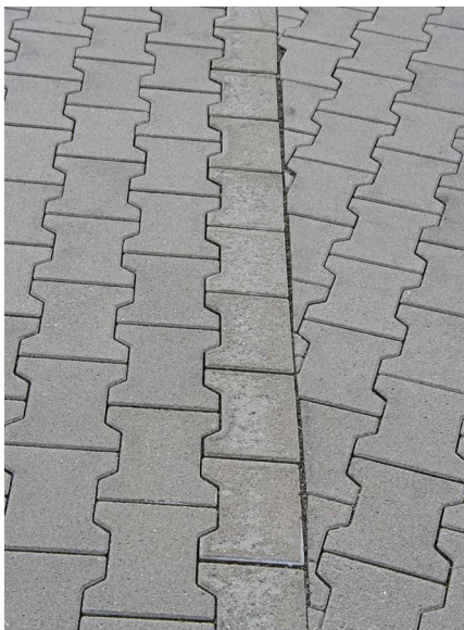
Abb. 2 a+b: Zementsteinabwitterungen an Betonpflastersteinen mit einer geringen Abwitterungstiefe
