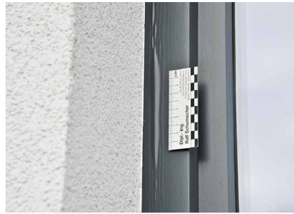
Abb. 5 + 6: Beispiele für sichtbare, linienförmige Hohllagen und punktförmige Bläschen
