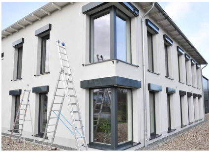
Abb. 4: Blick auf Festverglasungen im Bereich der Außenecken
