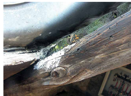
Abb. 4: Moderfäuleschaden
