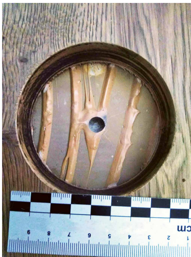
Abb. 6: Kleberwülste auf dem Estrich
