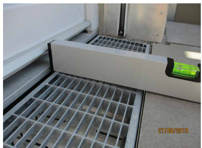
Abb. 1: Barrierefreier Terrassentüranschluss [Quelle: G. Göker]
